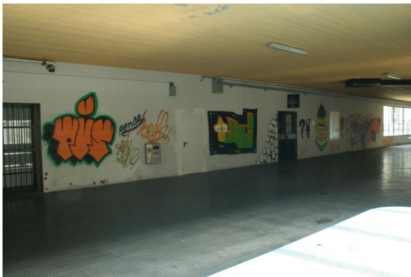
Il muro di 30 metri per RASC01
